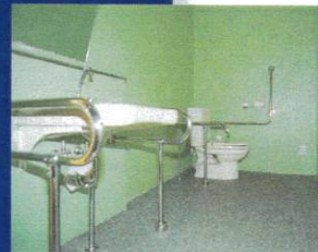
3号館レストラン 身障者用トイレ
